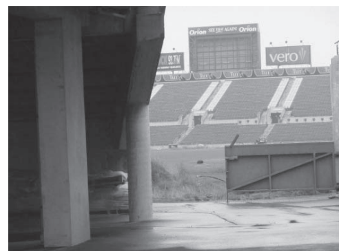
写真1, 2 取り壊しの進むAMIスタジアム
