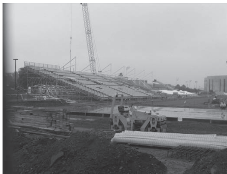
写真3、4 建設中のクライストチャーチスタジアム
