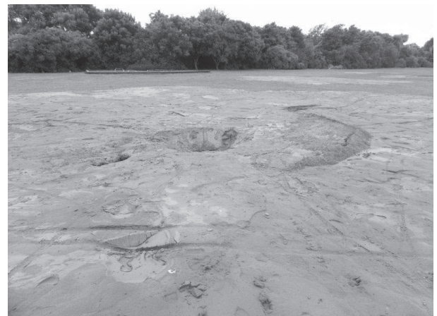
写真8 震災直後、液状化によって使用不能になった Parklands RFC のグラウンド (Maulice Lawlor 氏 提供)
