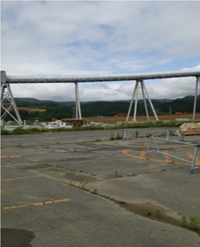
かさ上げ工事のための ベルトコンベア (陸前高田市)
